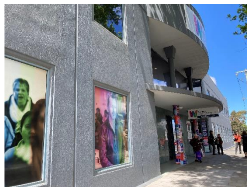
センターの外観
