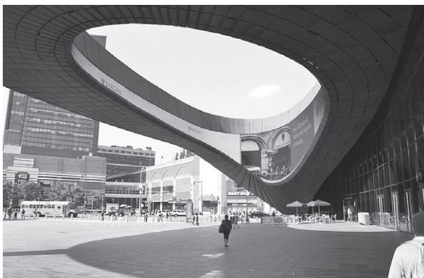
パークレイズセンター内部
