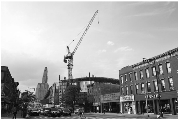
建設中のアトランティックヤード再開発
