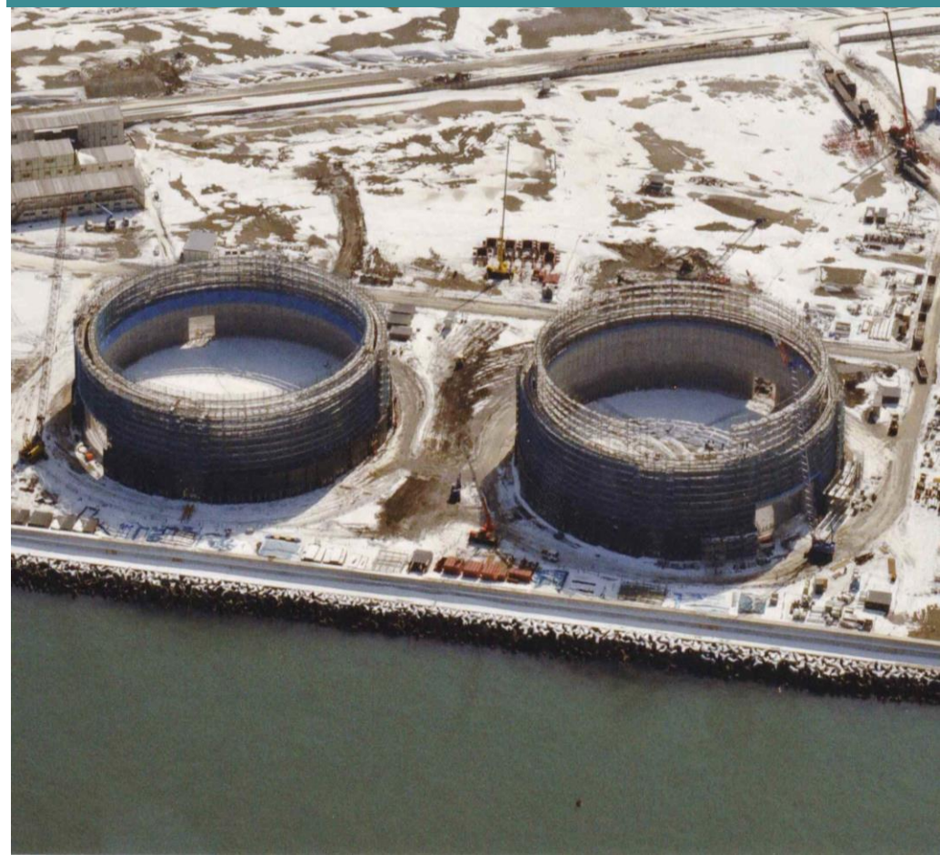
LNG terminal, March 2012
