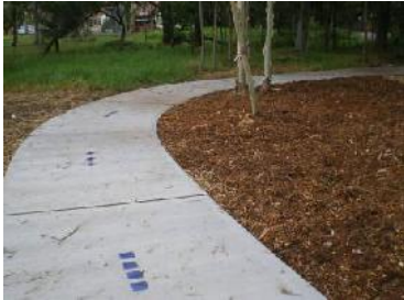
P & Cによる遊歩道の工事
