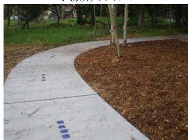
P & Cによる遊歩道の工事
